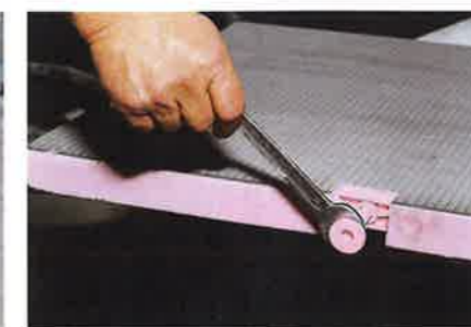
11 | Nastavenie podpier vaňového elementu
