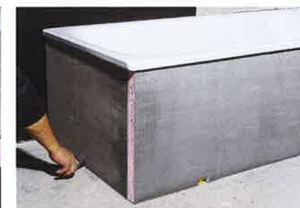
12 | Opláštenie vane
