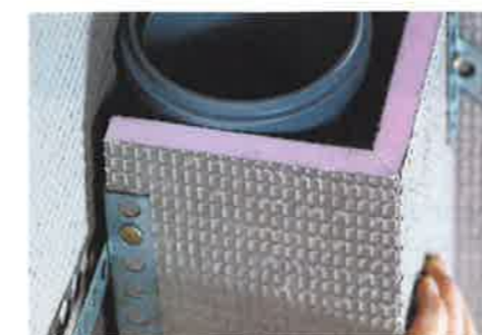
10 | Opláštenie potrubia
