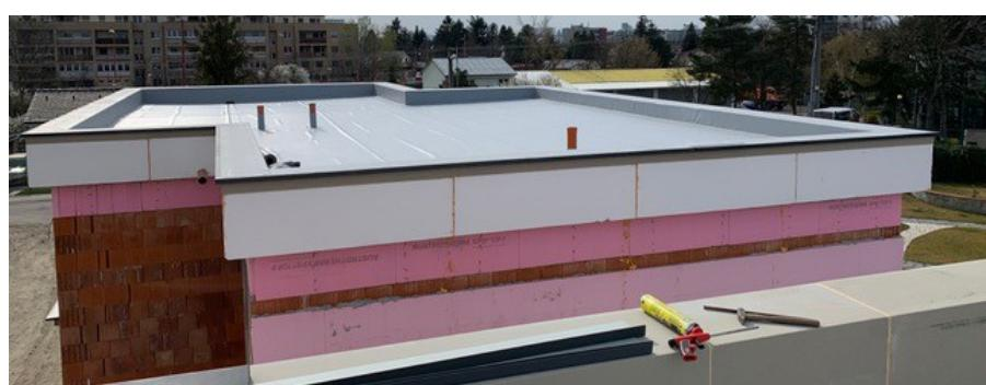
6. Mechanické upevnenie sa vykonáva pomocou PVC uholníka do existujúceho podkladu.
