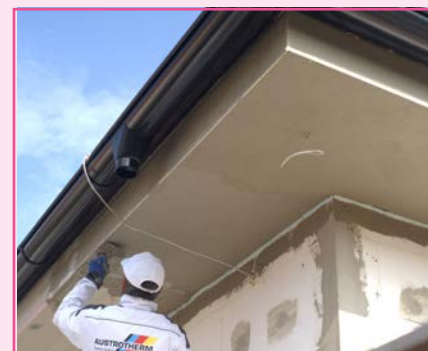
Prearmovanie podbitia – iba spoje UNIPLATNÍ.
