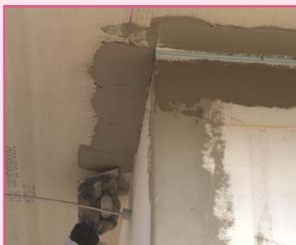
Osadenie dilatačnej lišty.
