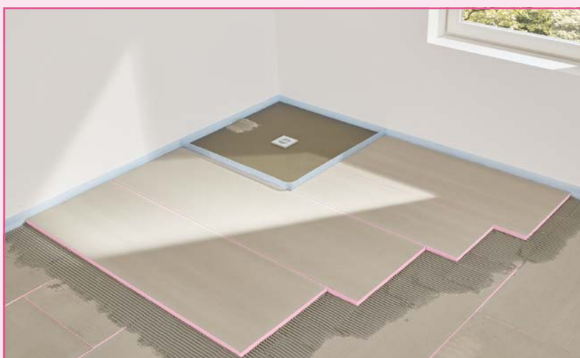
Podklad pod dlažby v kúpeľni.
