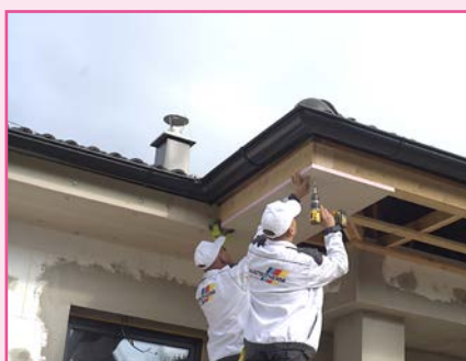
Jednoduché a rýchle kotvenie – kotvy max. 6 ks na 1 ks UNIPLATNE.
