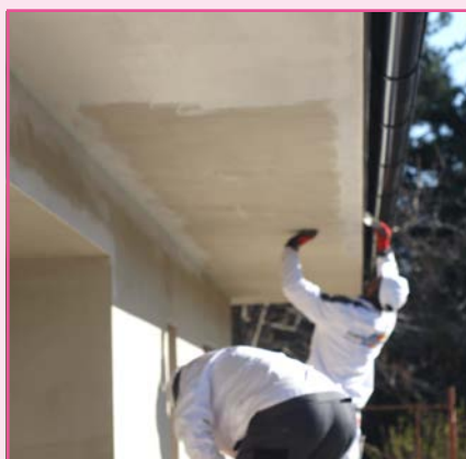
Aplikácia penetračného náteru pred fasádnou omietkou.
