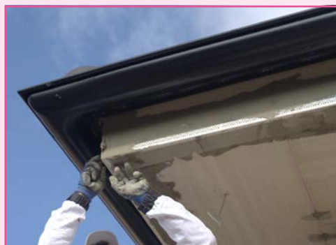
Osadenie odkvapovej / rohovej lišty.
