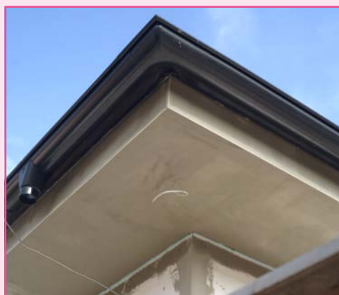
Celoplošné prearmovanie podbitia.
