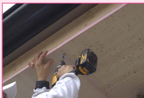
Kotvenie UNIPLATNÍ pomocou samoreznej skrutky a UNI podložky.
