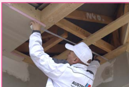
Kotvenie UNIPLATNÍ na pripravenú drevenú konštrukciu.
