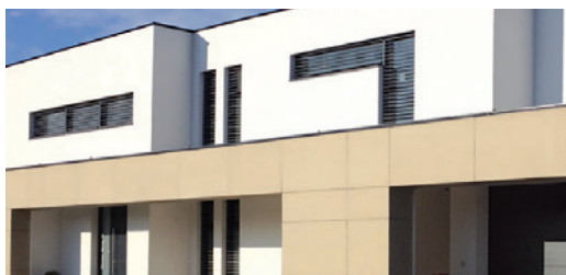
Fassadendämmplatte mit Austrotherm Beschichtungsmasse TOP.
