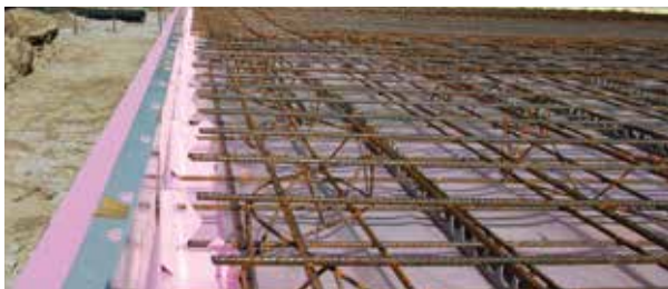
Vystuženie (armovanie) základovej dosky.
