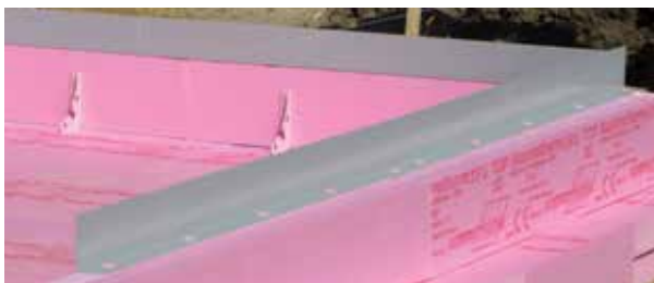
Vytvorené debnenie základovej dosky.
