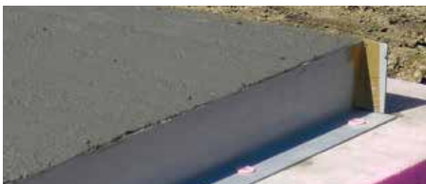
Finálne zabetónovanie základovej dosky.
