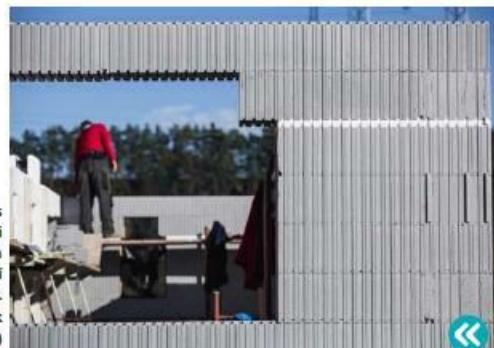
**STRATENÁ DEBNENIE.** Ucelený stavebný systém Variant-Haus umožňuje postaviť dom s vynikajúcimi tepelnoizolačnými vlastnosťami v rekordne krátkom čase. Ide o systém nenosného strateného debnenia z dutých tvárníc z tepelnoizolačného materiálu, ktoré sa po vyskladaní zalejú betónom a po jeho zatvrdnutí slúžia ako účinná tepelná izolácia. Systémy strateného debnenia majú svoje prednosti, ich realizáciu však treba nechať na stavebnú firmu. ([www.polyform.sk](http://www.polyform.sk))
