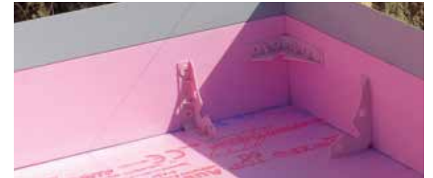
Debnenie základovej dosky.
