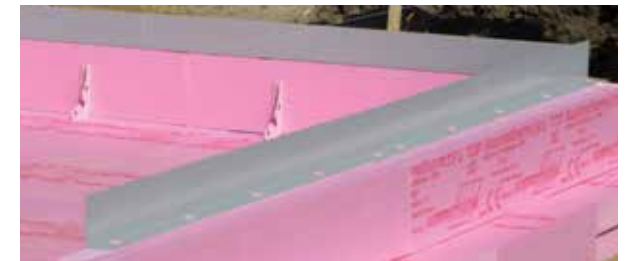
Vytvorené debnenie základovej dosky.
