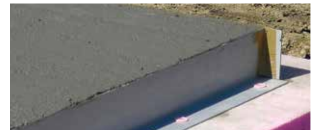
Finálne zabetónovanie základovej dosky.
