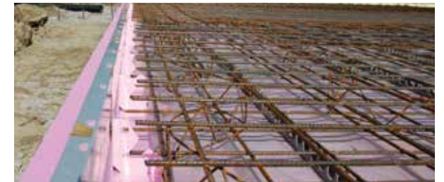
Vystuženie (armovanie) základovej dosky.
